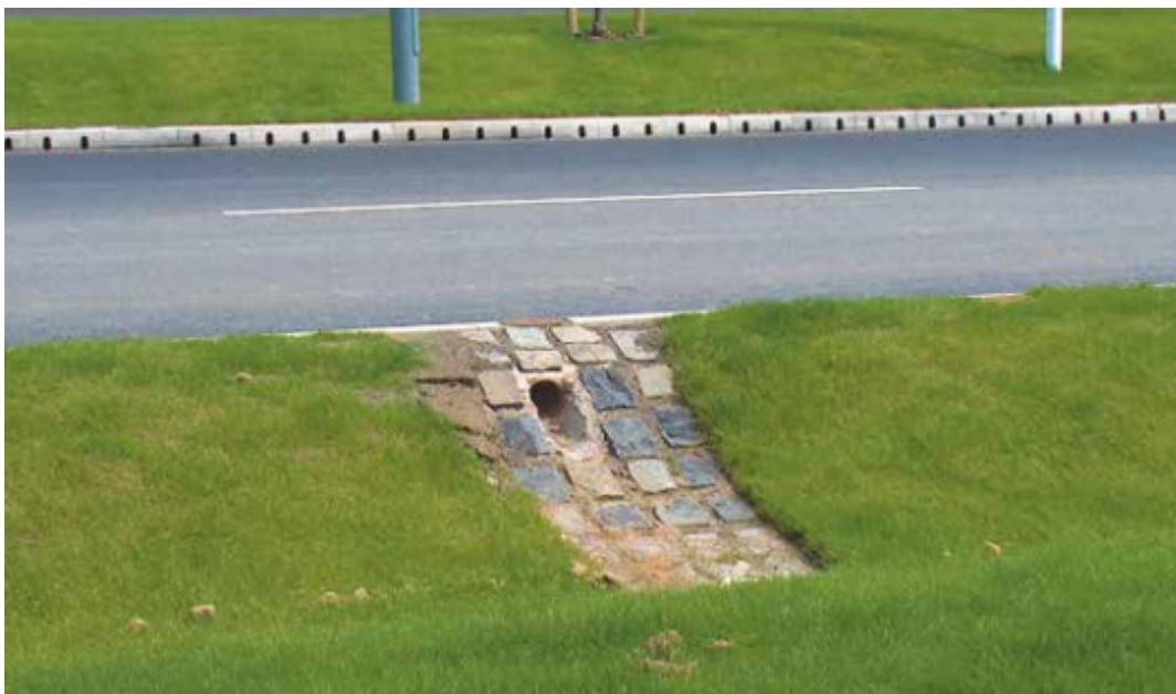
Figure 21. Système de collecte des bordures et rigoles pour le drainage de la chaussée. Source: ACO.
